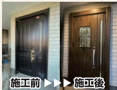
施工前 ▶▶▶ 施工後
