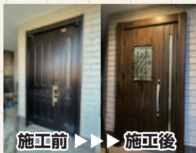
施工前 ▶▶▶ 施工後
